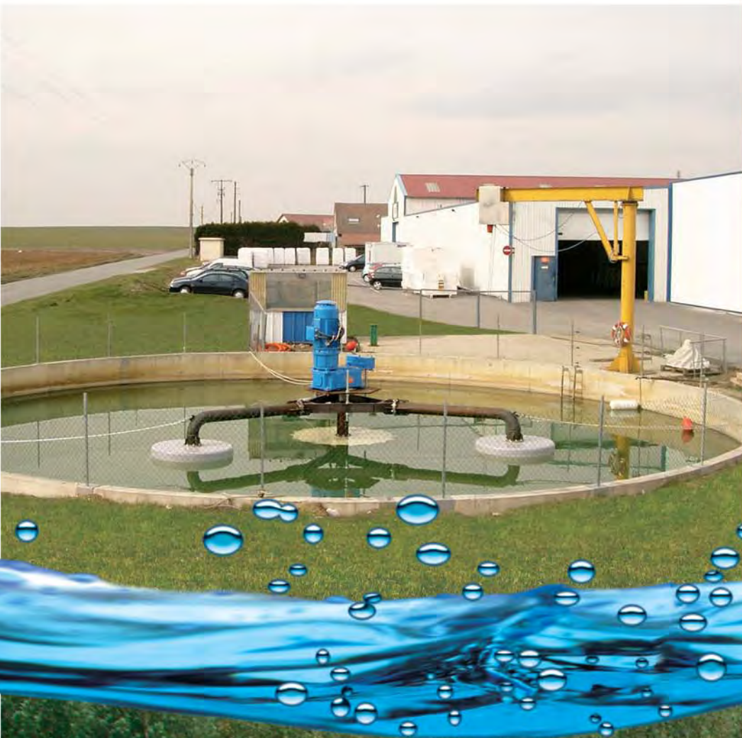
Bassin d'essai en génie civil de 1 000m 3 Concrete test tank - Volume 1000 m 3
